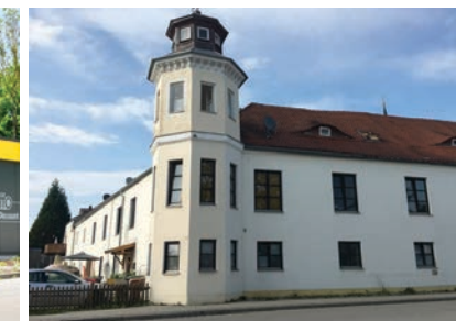
Altes Schloss Weng | Denkmalsanierung
